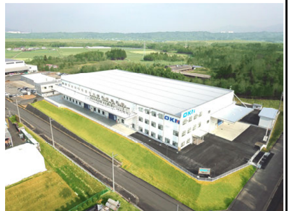
（株）オーケーエム「滋賀東近江工場」
